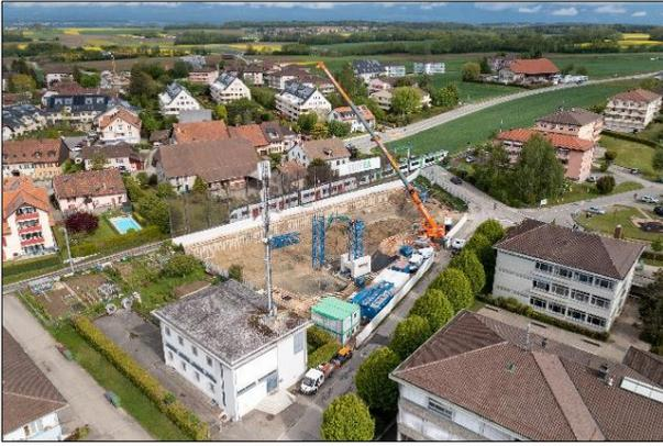
Le bâtiment fonctionne sur le principe de champ de sonde géothermique<sup>4</sup>, composée de 12 forages de 300 mètres chacun, disposés sur tout le tour du bâtiment.
