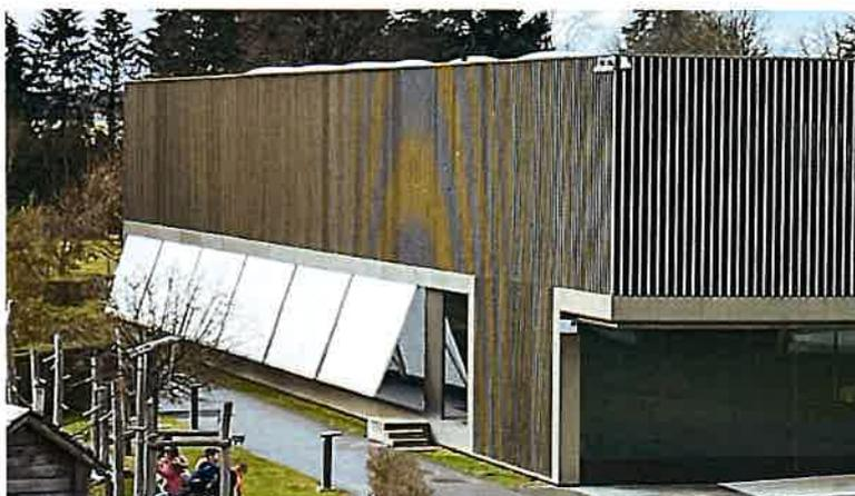
**Signalétique :** Il est prévu le marquage des éléments en verre pour en assurer la visibilité. En effet, un risque de collision existe avec les portes en verre et vitrages aménagés sur toute la hauteur sans profil horizontal supplémentaire.
