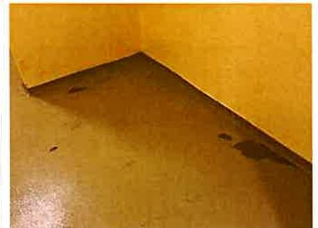
**Remplacement du revêtement synthétique du couloir d'accès aux vestiaires** : Il est également prévu de remplacer le revêtement synthétique du couloir, cloqué par endroits, par du carrelage, plus simple à l'entretien.
