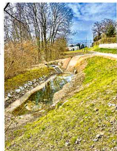
Illustration d'un bassin de rétention
